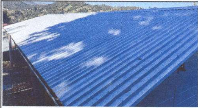
Foto 1: Sustrucción de lámina acanalada por lámina troquelada aluzinc calibre 26
