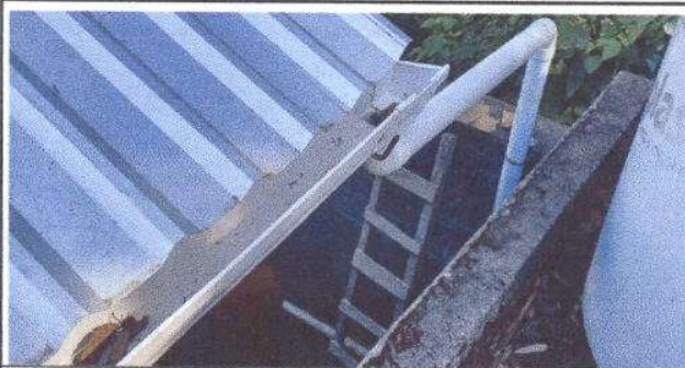
Foto 5: Sustrucción de canal de PVC y accesorios
