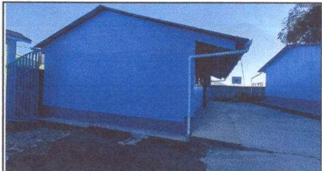
Foto 4: Sustrucción de bajadas de agua pluvial tubo pvc 3" y accesorios
