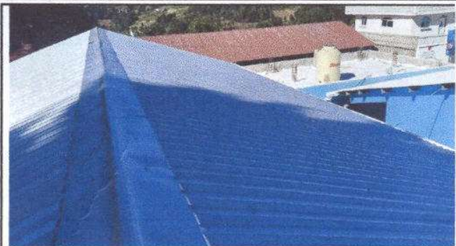
Foto 2: Sustrucción de elementos de fijación
