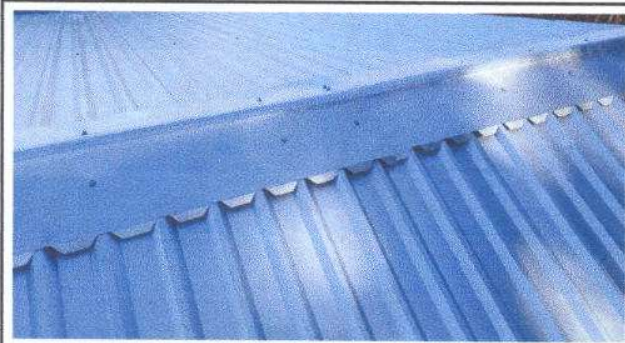
Foto 3: Sustrucción de capote de lámina
